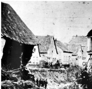
Teilansicht der noch intakten Häuserzeile auf der Westseite des Oberdorfs
