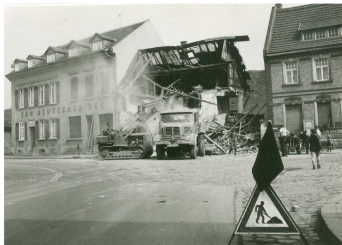
1967 Abriss des Hauses Eschborn
